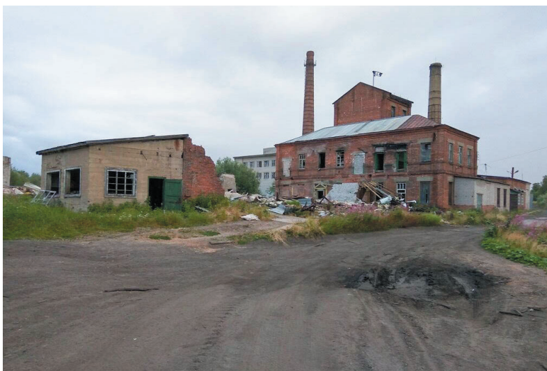
Рис. 5. Остаток пристройки к лесопильному цеху Мезенского лесозавода (поселок Каменка). 2018 г. (Фотографии из архива автора)
