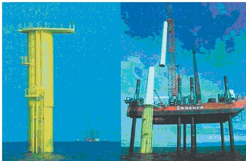
Рис. 5. Монтаж башни с помощью самоподъемного судна «Seacore»: а — нижняя часть; б — верхняя часть
